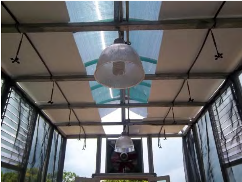
Figura 31. Colocación de malla sombra y plafón falso en el invernadero.
